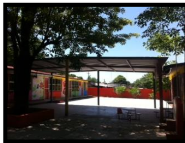
Imagen 7. Techo de patio
