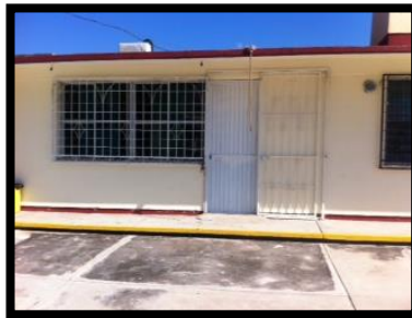
Imagen 8. Ventanales y puerta
