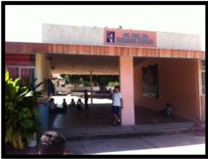
Imagen 1. Fachada de la escuela
