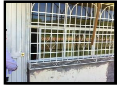
Imagen 6. Puerta y ventanales
