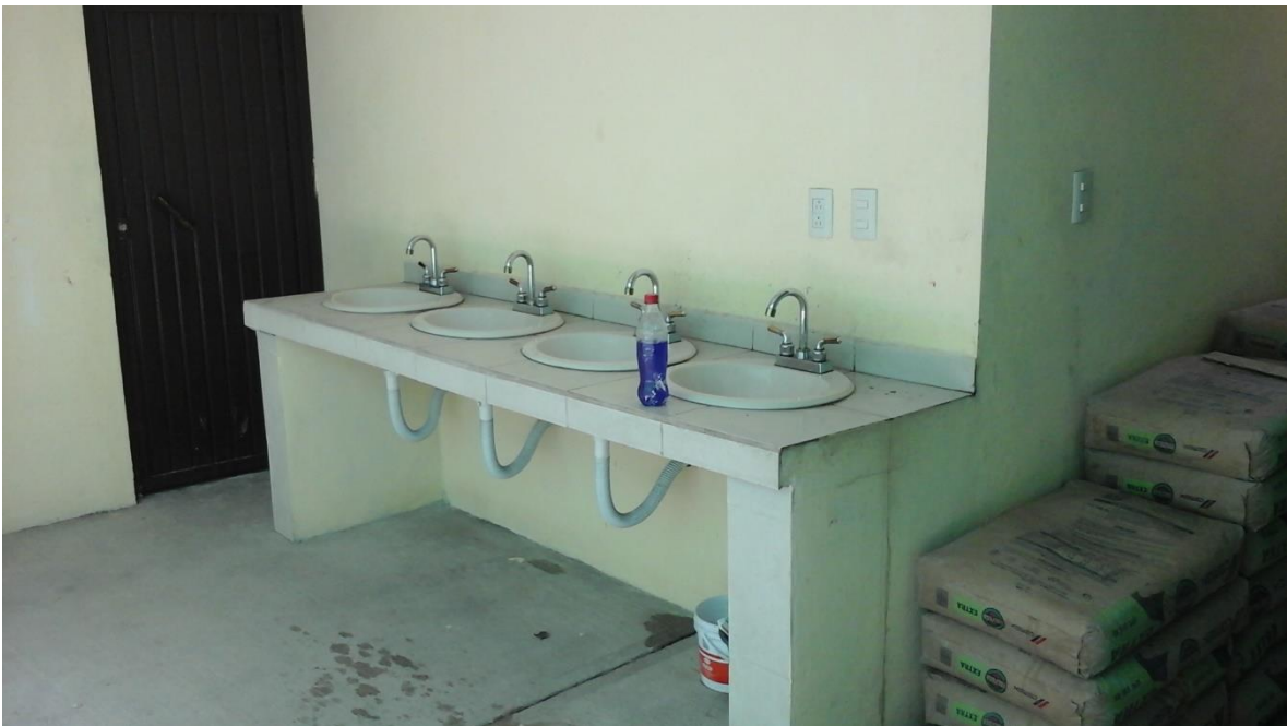
Sanitarios, Escuela Primaria General “Filomeno Mata”
