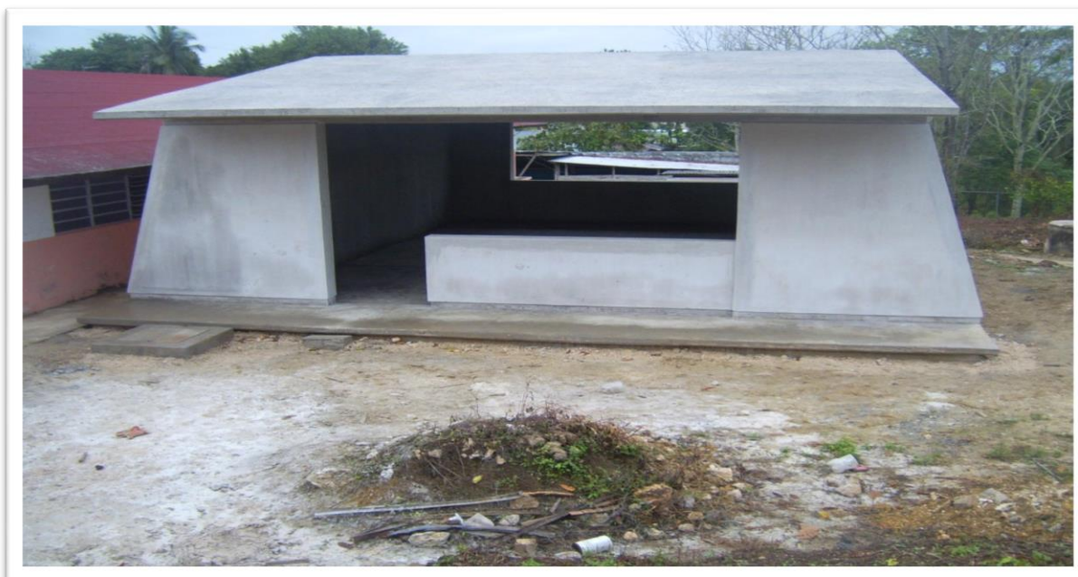
Foto: Construcción de aula. Primaria Expropiación Petrolera, Lázaro Cárdenas, Palenque, Chiapas.
