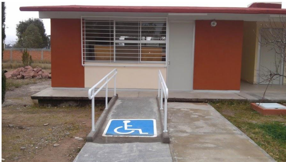
Foto: rampa para silla de ruedas escuela Francisco I. Madero, SLP.
